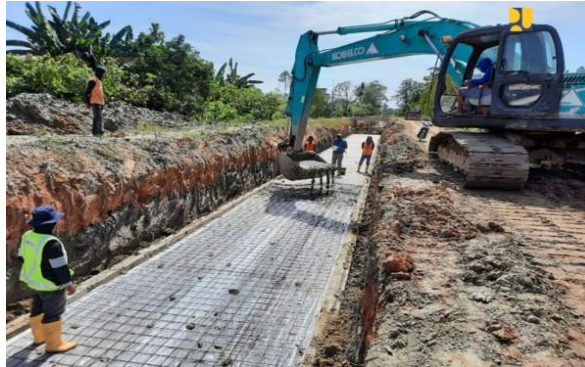
Gambar 2. Pembangunan dan rehabilitasi jaringan irigasi Baliase
