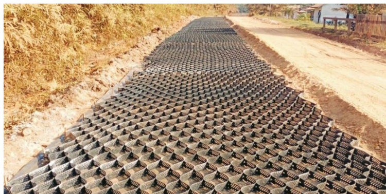
Gambar 4. Lapisan geocell tersebar di seluruh ruas jalan
