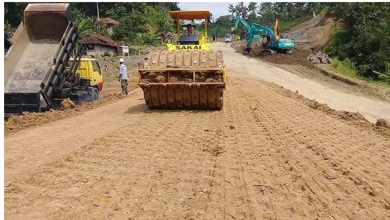
Gambar 6. Pemadatan dengan roller getar
