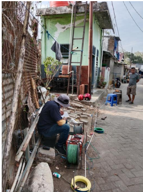
Gambar 4. Pengambilan data geolistrik resistivitas
