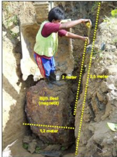
Gambar 4. Tes pit simulasi geomagnet
