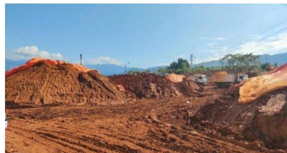
Gambar 6. Tumpukan yang Dilakukan Buka Tutup Terpal
