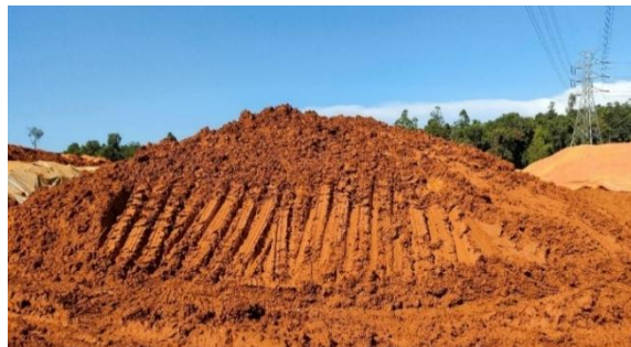
Gambar 5. Tumpukan yang Sudah Dilakukan Pemasatan
